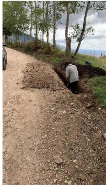
Imagen 1 Excavación para tubería
